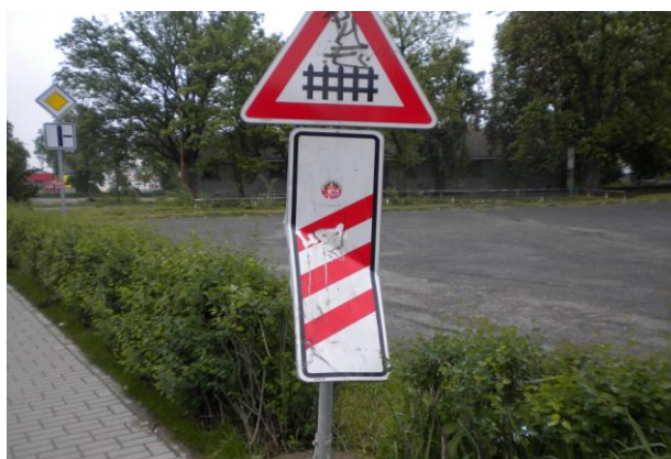
Poškozená dopravní značka ul. Armádní
